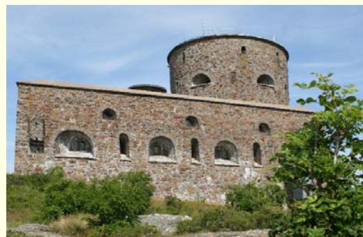
Imposante bis zu 6 Meter dicke Mauern
