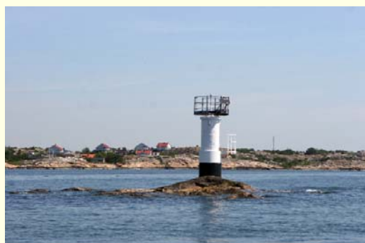
Seezeichen auf - teilweise - überspültem Felsen
